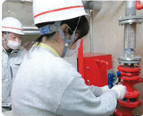
令和6年2月21日 スプリンクラー消火ポンプ弁操作訓練
